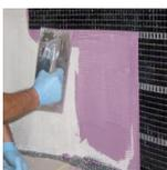
5- 用 3.5mm 锯齿抹刀将 Starlike® EVO 作为粘合剂直接涂到支承面上。
