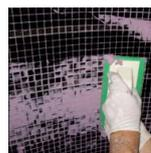
6- 使用橡皮刮刀将 Starlike® EVO 作为密封材料涂抹在接缝上。
