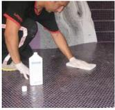
9— 透明产品灌浆表面上的污点和残余物可以在 24 小时后使用特制清洁剂 LITONET 清除掉。用白毛毡将 LITONET EVO 抹在表面上并静置 15-30 分钟让其反应，再用白毛毡用力擦拭表面。
